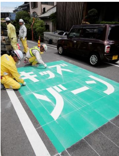
令和元年7月 大津市において新設された キッズゾーン
